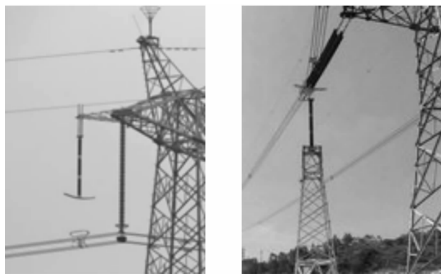
(a)直线塔安装方式 (b)耐张塔安装方式
