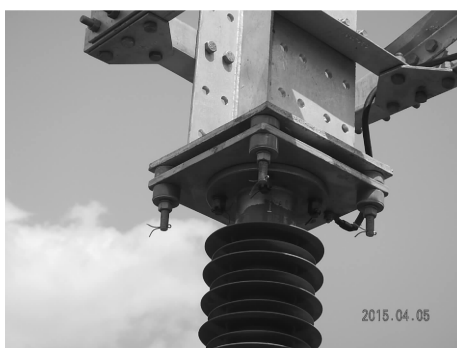
图4 直线塔底座安装情况
